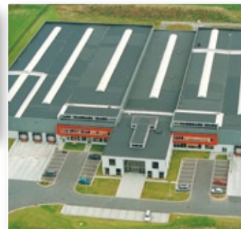
Unité de production "Fluides"
